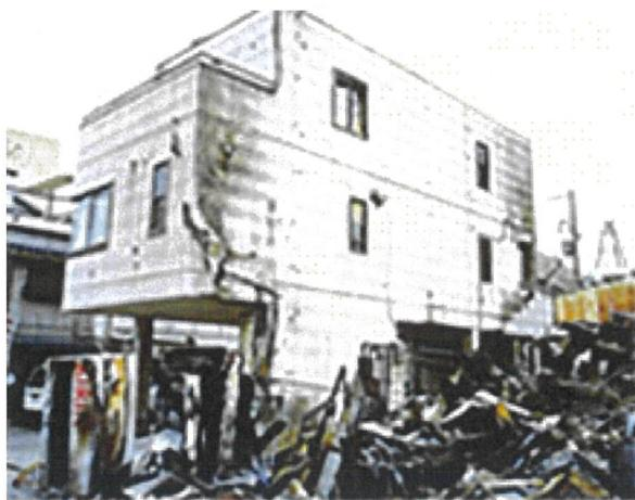
1995年の阪神・淡路大震災では、火災による被害も甚大でした。しかし、多くの住宅が焼失していく中にあって注目を集めたのが「ヘーベル」の耐火性能でした。激しい揺れに耐え、倒壊せずに残った「ヘーベル」が防火壁としての役割を果たし、延焼により被害拡大を防いだという事例が各所で見られました。
